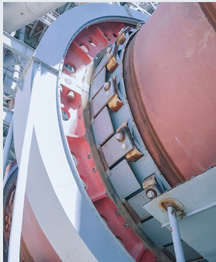
Die Abstützung erfolgt über Teleskopstützen
