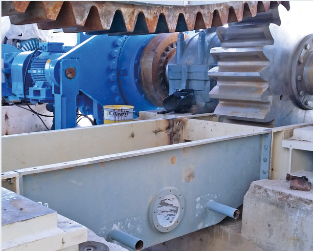
Montage der Ölwanne eines Doppelritzelantriebes
