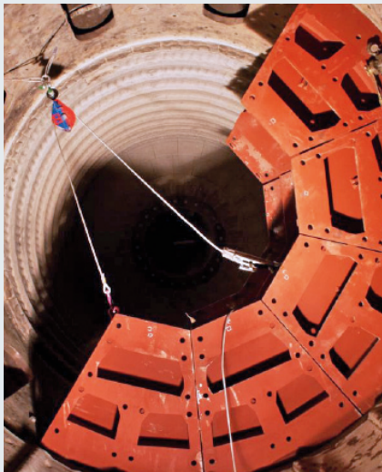
Montage des Wandgerüsts
