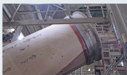
Pulverkühler bei der Demontage und während der Montage
