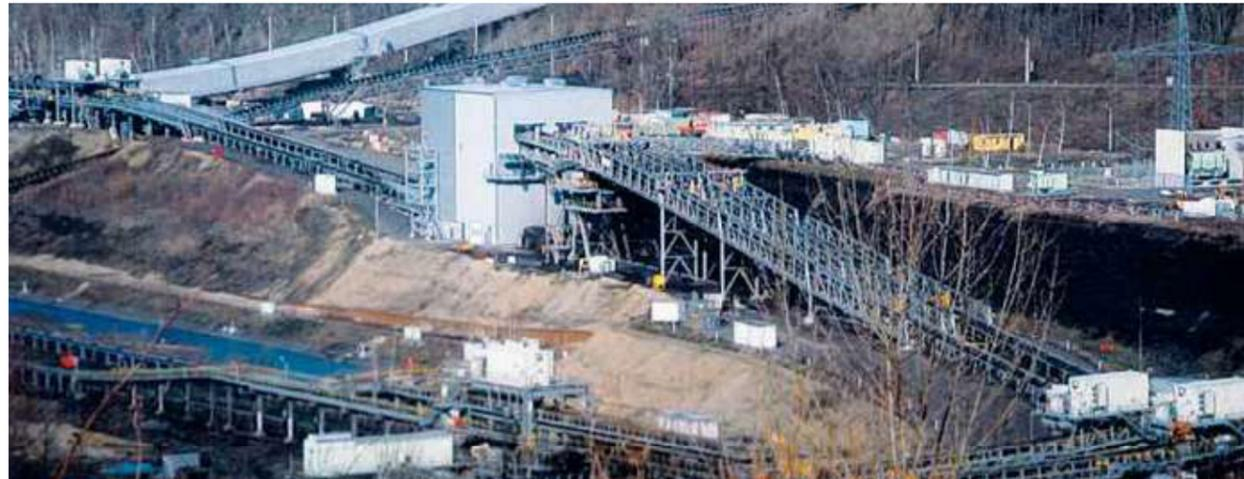
Anlage von thyssenkrupp Industrial Solutions zur Aufbereitung von Braunkohle. Im Einsatz 4 RollSizer DRS 660 x 3700 SideSizer.
