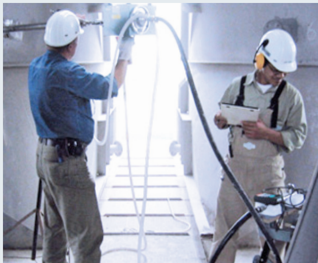
Staubmessung im Vorwärmer
