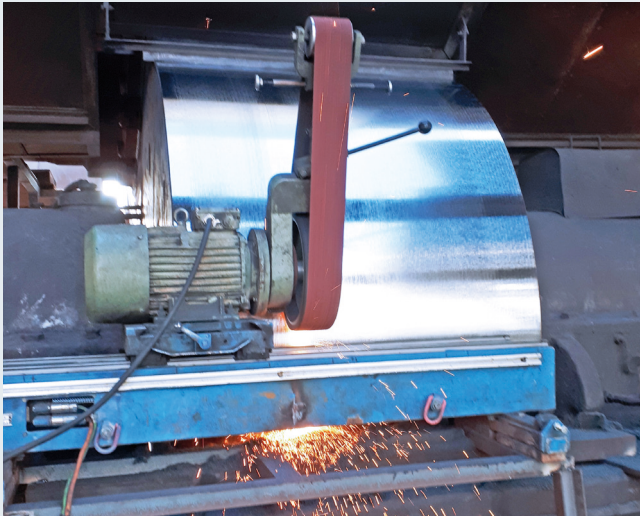
Schleifarbeiten am Laufring und einer Laufrolle
