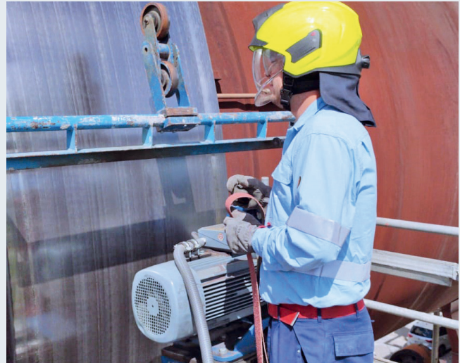
Durch den Einsatz von polgrind® laufen Laufringe und Laufrollen wieder rund.
