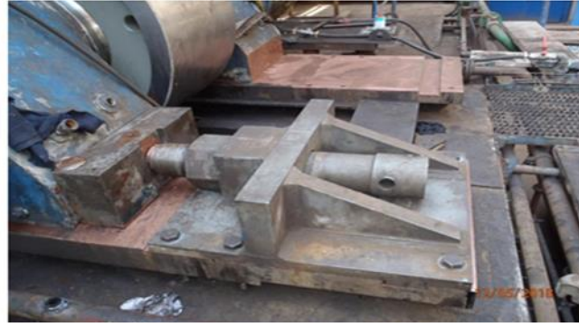
Montage der Druckböcke
