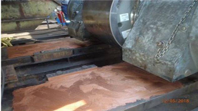
Sohlplatten mit Kupferpaste behandelt
