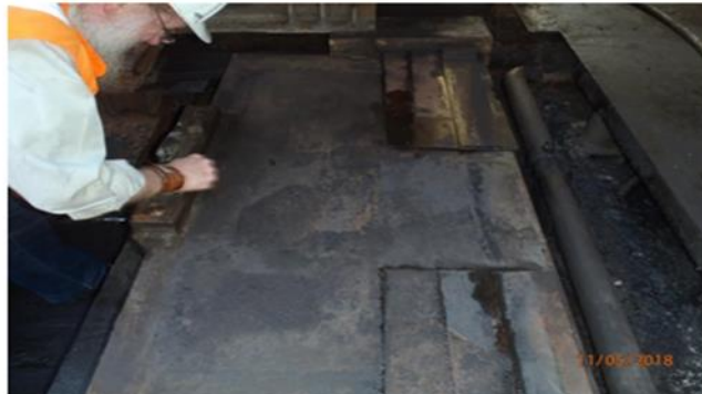
Begutachtung der Sohlplatten
