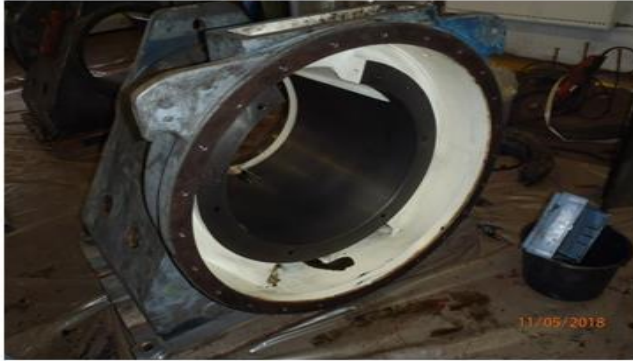
Vorbereitung der Lagergehäuse für die Montage
