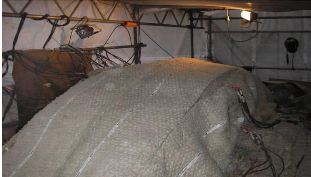
Abgedeckter Laufring während des Spannungsamglühens und des langsamen Abkühlens
