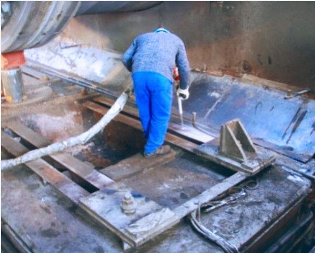
Ausbau der bisherigen Rolleneinheiten und Säubern der vorhandenen Sohlplatte. Arbeiten an der Sohlplatte und am Ofenfundament sind nicht notwendig.
